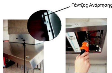
Οπή γάντζου ανάρτησης στο θάλαμο μοτέρ
